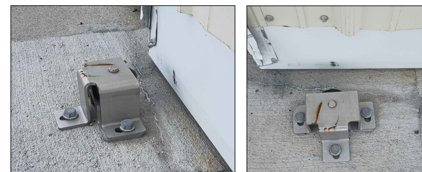
EXISTING HANGAR DOOR STOP
